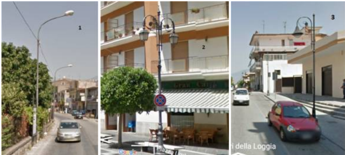
Figura T.2.1 Esempi di armature poco efficienti
